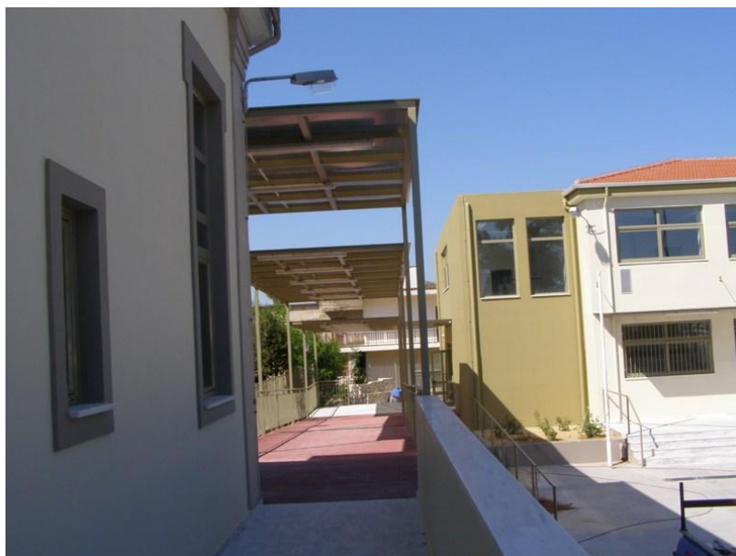
Στέγαστρο που ενώνει τα δύο κτίρια μέσω ράμπας
