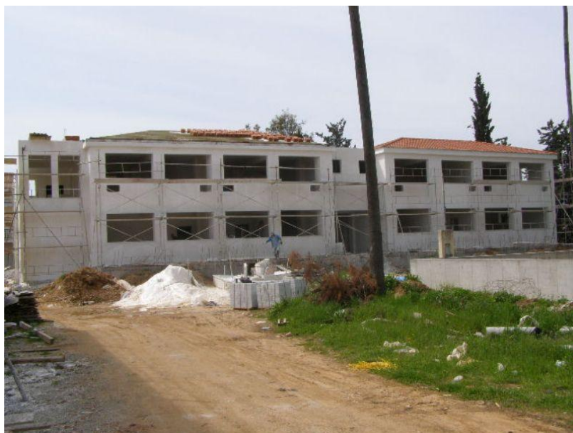
Κατασκευή κτιρίου αιθουσών διδασκαλίας
