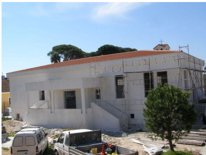
Κατασκευή κτιρίου πολλαπλών χρήσεων
